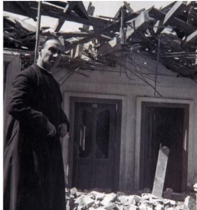
5. Broeder Van De Wiele bij het puin in de bovenste klassen van de Middelbare Landbouwschool, enkele weken na het bombardement van 17 mei 1940 op de Dalstraat en Molendreef (Archief Broeders Hiëronymieten).
