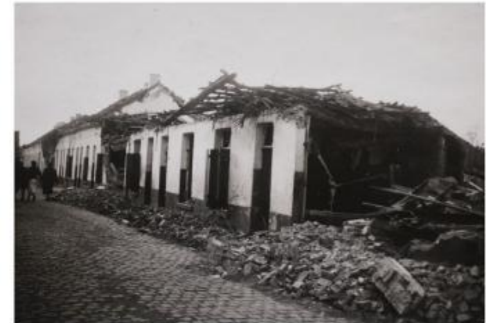
6. Schade aan arbeiderswoningen in de Molendreef na het bombardement van 17 mei 1940, waarbij verschillende buurtbewoners het leven lieten (Verzameling William Albertyn).
