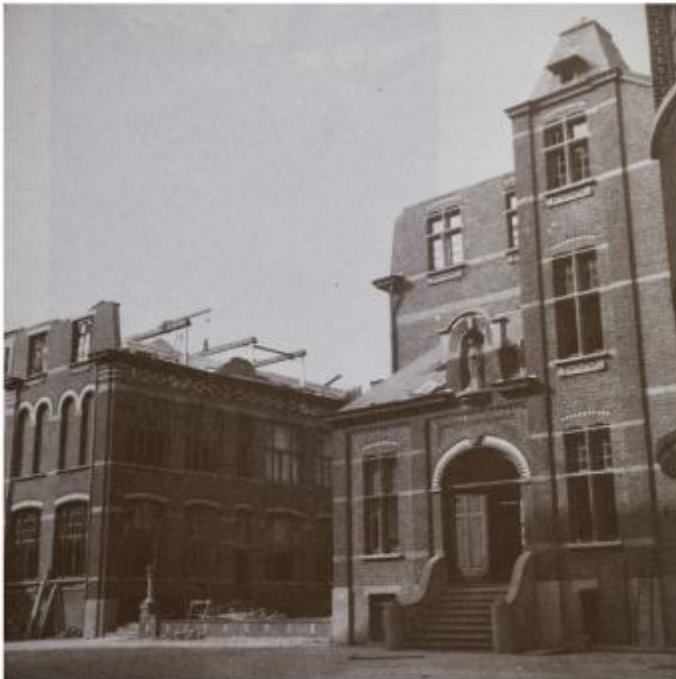
4. Voorgevel van de Middelbare Landbouwschool van de Broeders in de Molendreef na het bombardement van 17 mei 1940; de opruimings- en herstellingswerkzaamheden zijn al aan de gang (Archief Broeders Hiëronymieten).
